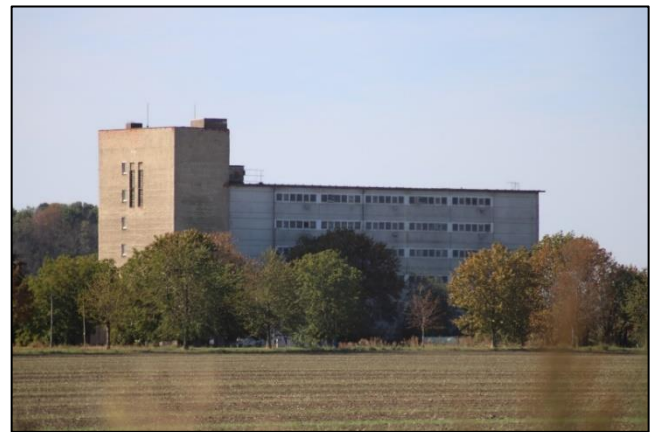
Abbildung 16 Ansicht des Schweinehochhauses in Maasdorf 40
